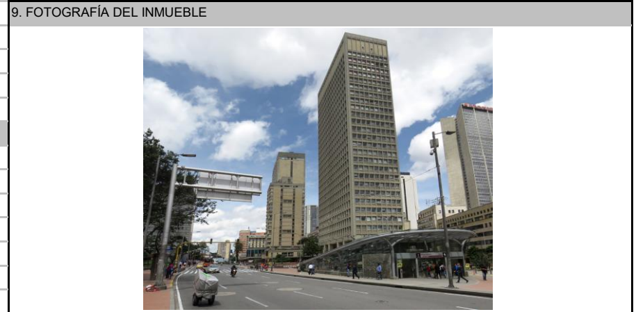
Fuente: Equipo Fotografía PEMP Patrimonio Inmueble
